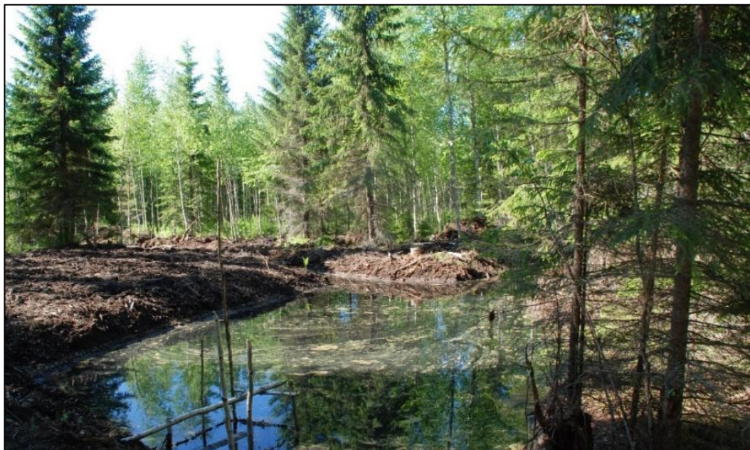
Kuva 7 Laskeutusallas mitoitetaan vesimäärälaskelmien mukaisesti. Altaalle on varattava hakkuiden yhteydessä riittävästi tilaa, jotta altain kaivuunmassat voidaan maisemoida huolellisesti. Lisäksi altaat kaivetaan kohtiin, joihin on järjestettävissä kulkuyh- teys altain tyhjennystä varten. Kuva: Samuli Joensuu
