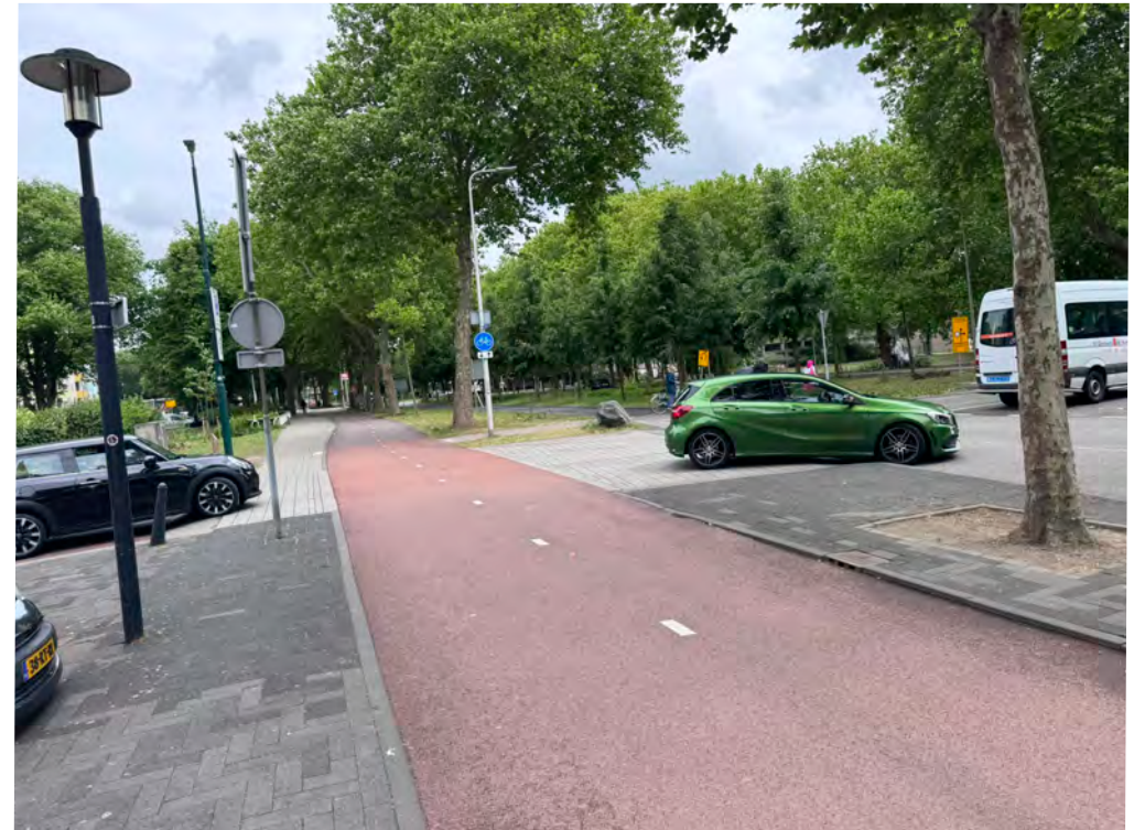
Kuva: Tyypillinen ylijatettu pyörätie pysäköintialueelta poistuttaessa. Infra viestii väistämismahdollisuudesta ( Sijainti Google Mapsissa ).
