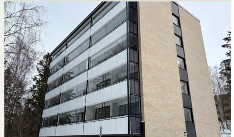
Asunto oy Säästökehä on ollut merkittävä hanke liikevaihdon puolesta.
