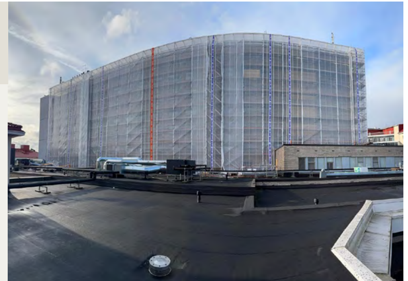
Tyks Mäntymäen sairaalan julkisivusaneeraus aloitettiin vuoden 2025 syyskuussa.
