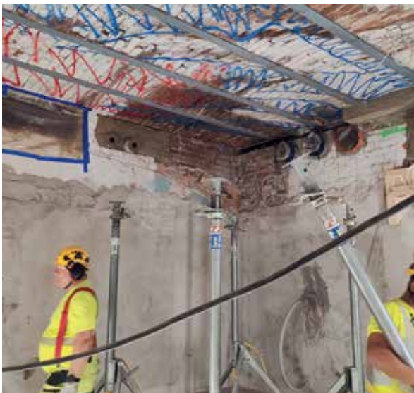
Työnaikaista suunnittelua työmaalla. Tilan kattoon hahmoteltu eri väreillä eri taloteknisten asennusten reitit. Tuuli Ranki
