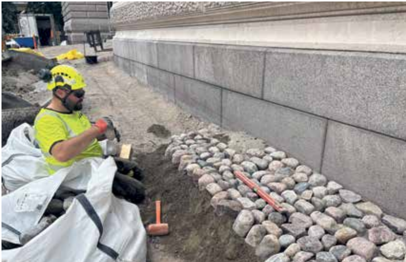
Vanha kenttäkiveys varastoitiin, pestiin ja käytettiin uudelleen. SF
