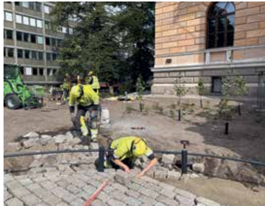
Kiveysten asennustyö käynnissä Snellmaninkadun puolella elokuussa 2025. Syreenit saavat kasvaa rungollisiksi. SF
