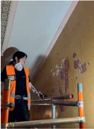
1904 tehdyn keltaisen marmoroinnin alta pilkistää vuoden 1891 tumma tiilenpunainen liimamaali.
