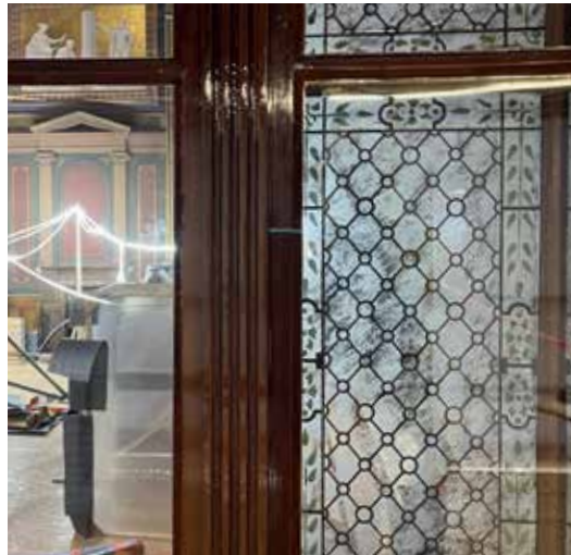
Porvariston salin työmaatunnelmaa julkisivutelineiltä katsottuna. Telineiden takia himmennyksen kokonaisvaikutelmaa ei päässyt tarkastelemaan luonnonvalossa.
