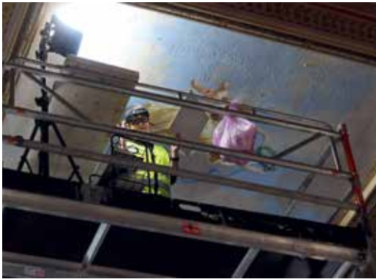
Arja Sorri telineillä mielityössään kiinnittämässä maalauspinnoja. Arja toimi Säätytalon peruskorjauksen pääkonservatorina ja veti oman yrityksensä kuustie&sorri Oy:n kymmenhenkistä konservattoriryhmää. KW
