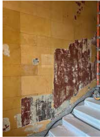
Pudotuksen yhteydessä saatiin esiin myös seinän alkuperäinen jäsentely: hyvin tummat, lähes mustat kehykset rajasivat kenttiä. Nousun kohdalla on ollut yksi pitkä kenttä ilman väljakoja.
