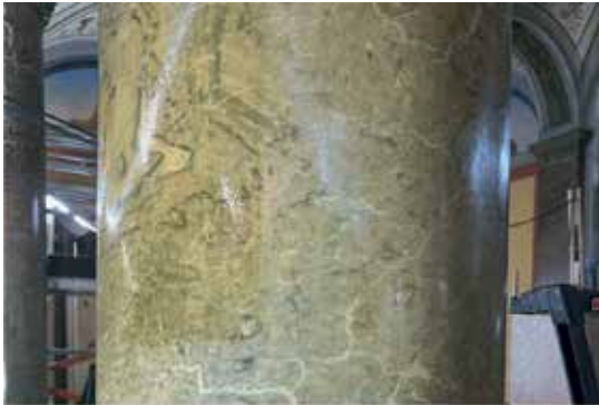
Vestibyylin pylväästä on poistettu kellertävää lakkaa, alta paljastuu sinertävä kivijäljitelmä. SF
