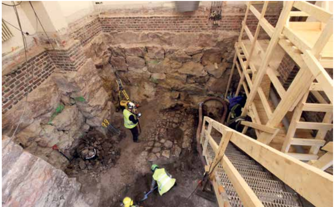
Piha- tai tiekiveys 1800-luvun rakennuksen alla.
