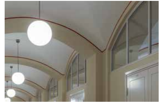
Pohjakerroksessa kevyiden väliseinien yläosa on lasia, jolloin holvien jatkuvo näkyy tilasta toiseen. Pohjakerroksen 1990-luvun pallovalaisimia muokattiin lisäämällä niihin niklattu varsi ja kattokupu. ADLC
