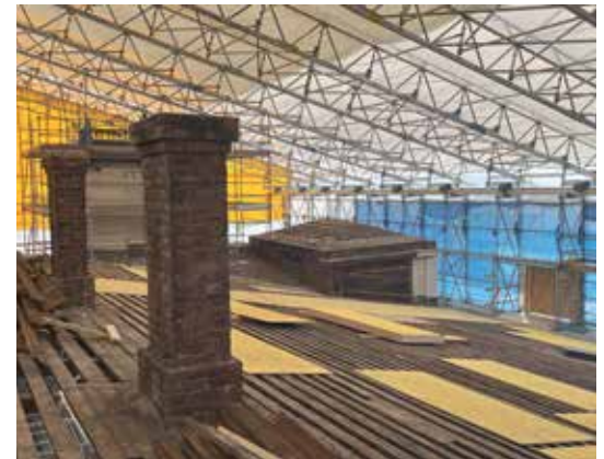
Vesikaton purkutyöt aloitettiin vasta kun sääsuoja Mammutti oli paikallaan. SF
