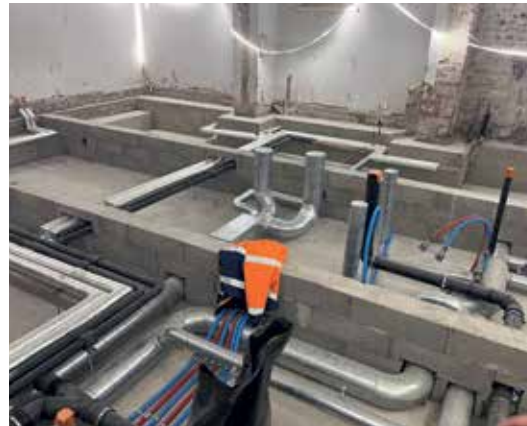
Pohjakerroksen taloteknisen asennustilan pohjalaatta (kaksoislaatan alempi laatta) valettuna ja liittolaatan (kaksoislaatan ylemmän laatan) välitukina toimivat muuraukset tehtynä. Syntyneeseen välitilaan asennettiin talotekniikkaa. SF
