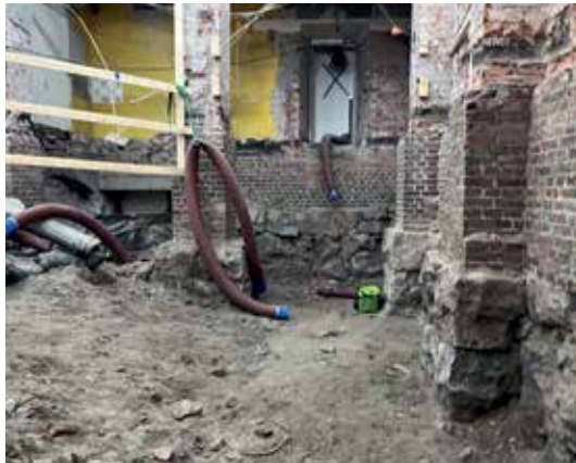
Keittiön alapuoliset maatäytöt kaivettuna pois ennen uuden taloteknisen asennustilan lattian tekoa keittiön alapuolelle. Reino Huuskonen
