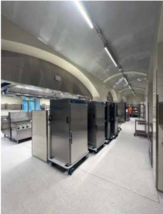
Pohjakerroksen laitoskeittiö uusittiin kokonaan. Säätytalolle ominaiset tynnyriholvit ovat esillä siellä missä kohdeilmastointia ei tarvita. Uudet laitteet ja pinnat ovat joko ruostumatonta terästä tai luunvalkoista kaakelia. Kaari-ikkunoiden smyygit hiomaalattiin peilaavan sileiksi. Simo Freese
