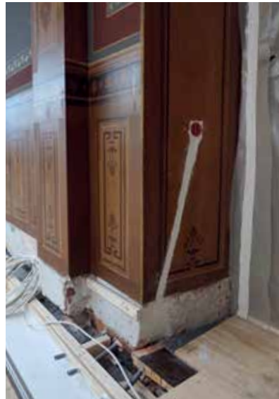
Kuvasarja sähköroilon paikkauksesta.
