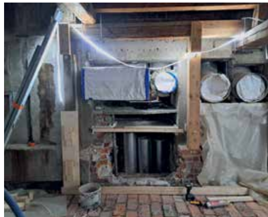
Uudet ilmanvaihtokanavien asennukset ja asennuksiin liittyvien rakenteellisten tuentojen teko käynnissä. Tuuli Ranki
