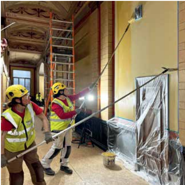
Tehokas työskentely vaati kaksi maalaria, joista toinen levitti maalin ja toinen tasoitti sen. Kuvassa maalataan keskushallin seinien pohjamaalia. Riitta Karjalainen
