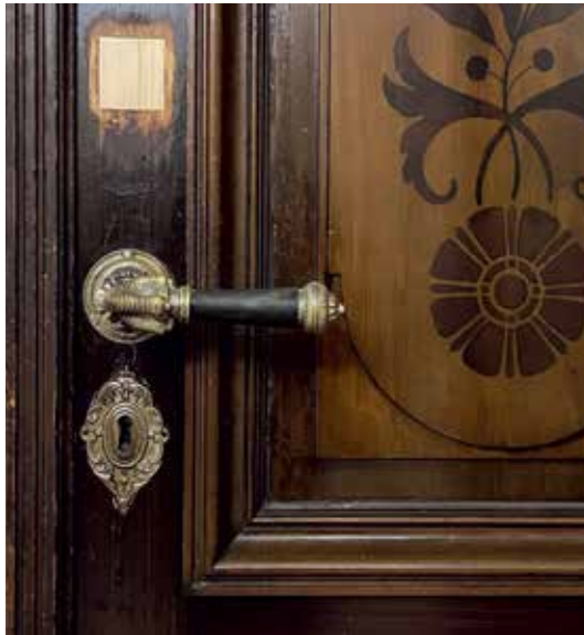
Ovesta poistetun lukon tilalle on laitettu puupaikka. KW
