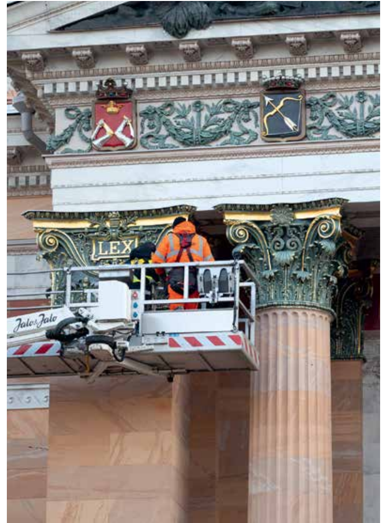
Vaakunoihin on toteutettu heraldiset värit ja välissä olevat kipsiköynnökset on maalattu patinoituneen pronssin sävyyn. SR
