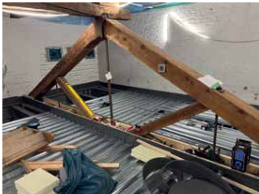
Ullakon uuden ilmanvaihtokonehuoneen lattia-rakenteen rakennustyöt käynnissä. Liittolaatta sovitettiin alkuperäisten ansaiden keskelle. Reino Huuskonen
