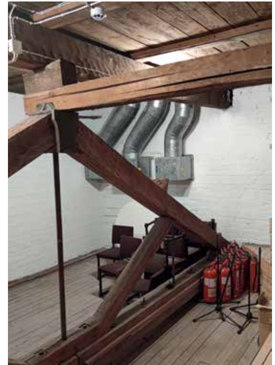
Kolmannen kerroksen nurkkahuoneissa on puuta ja metallia yhdistävät ansarakenteet. Näiden väliin rakennettiin uudet konehuoneet. Tuuli Ranki
