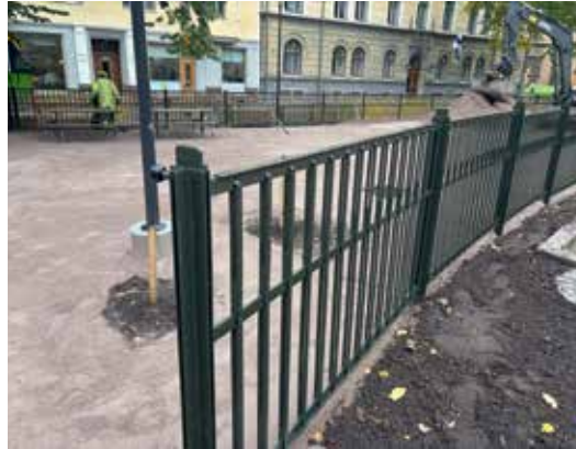
1990-luvulla rakennettu teräsaita säilytettiin arvokkaana kerrostumana, kunnostettiin ja korotettiin vastaamaan nykymääräyksiä. SF
