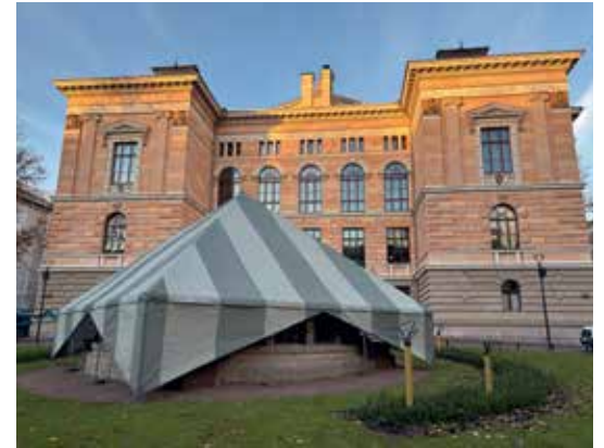
Suihkulähde on saanut uuden katoksen ja julkisivut on paljastettu telineistä. Muutto takaisin voi alkaa. SF
