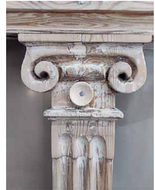
Karmin joonialaisen kapiteelin alla oleva pyöreä nappi on uusittu. Iina Lautala
