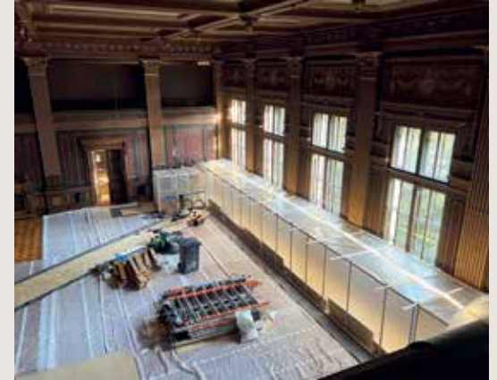
Papiston salin suojauksia. Lattioiden reunojen avaukset tehtiin suojakopeissa, ettei pöly leviäisi tiloihin. TN
