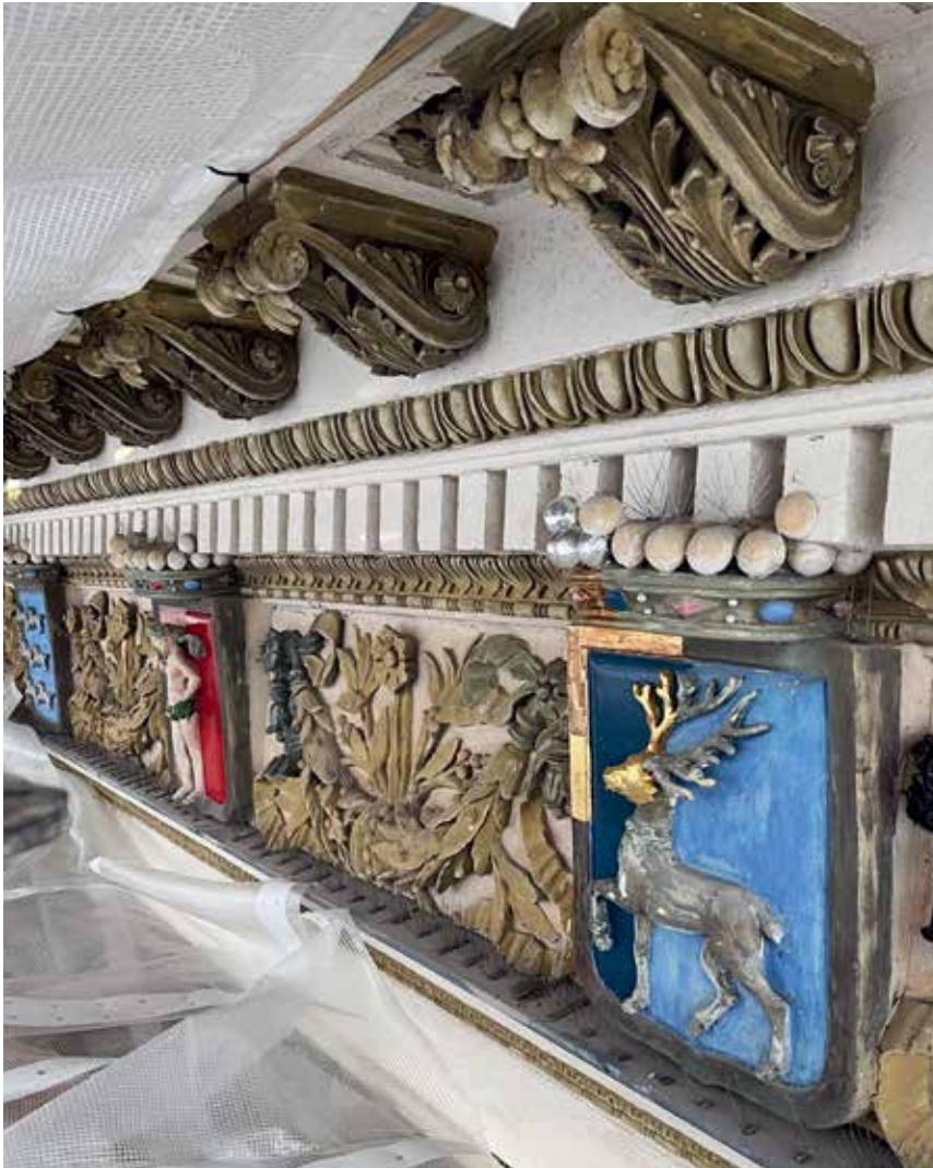
Säätytalon julkisivun koristeellisia konsoleja ja vaakunoita odottamassa restaurointivuoroaan. Vaakunoihin ja köynnöksiin on tehty värimalleja, joiden avulla päätetään lopullinen sävy ja toteutus. Marja-Leena Lehtimäki
