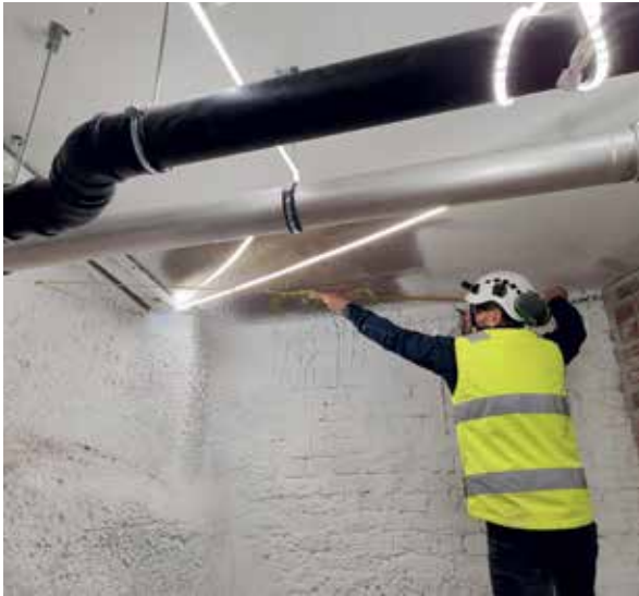
Työnaikaista suunnittelua työmaalla. Jouni Allonen osoittaa mittanauhalla tulevan teräspalkin sijaintia. Kattoon on mustalla tussilla merkitty rakenneskannauksen perusteella havaitut olemassa olevan rakenteen raudoitusten sijainnit. Kuva Tuuli Ranki.
