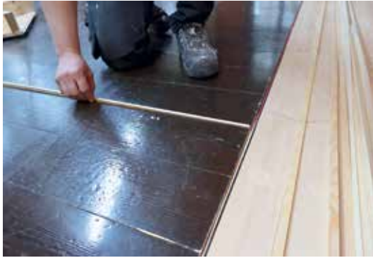
Kuura Helanen sovittaa induktiosilmukan uran päälle ohuesta rimasta tehtyä ”kantta”. KW
