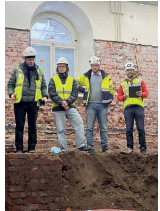
Ratkaisuiden hakeminen paikan päällä työmaalla oli antoisinta. Suunnittelupalaverissa kuopan reunalla arkkitehdit Simo Freese ja Iiro Ristikankare, työmaainsinööri Samuli Siivo ja rakennuttajakonsultti Oskari Peurakoski. TN
