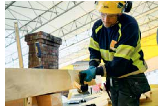
Restaurointikirvesmies Ilpo Heikkinen veistää piilukirveellä kattorakenteen hirttä. Jussi Helttunen/Rakennuslehti
