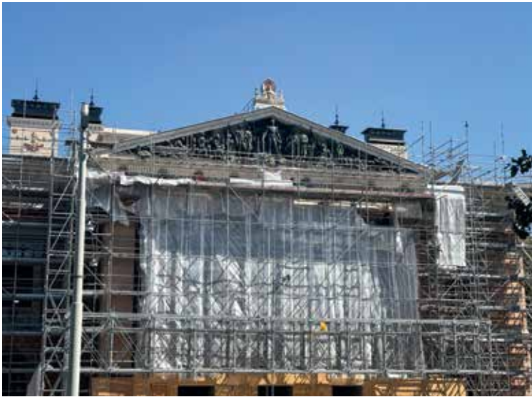
Konservoitu veistos paljastuu telineiden ja pressujen takaa. Näkykö verkko? SF
