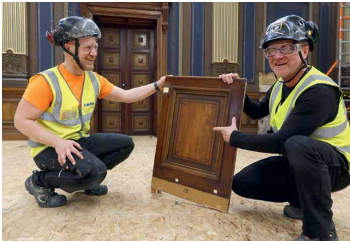
Kuura Helanen (vas.) ja Tony Lidman (oik.) näyttävät esimerkin tyypillisistä pienistä upotuspaikkauksista. Tässä on korjattu seinäpaneelin vanhoja kiinnityskohtia ja vanhan vesijohdon läpiviennin kohta. KW
