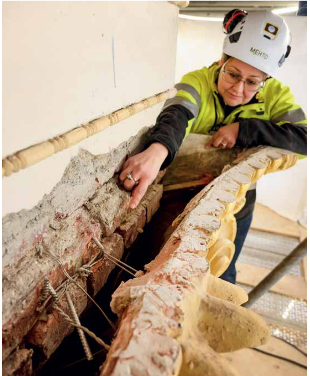
Tuuli Ranki toimi Säätytalon työmaan rakennesuunnittelun projektipäällikkönä. Kuvassa hän tarkastaa kipsikapiteelien kiinnityksiä. Jussi Helttunen/Rakennuslehti
