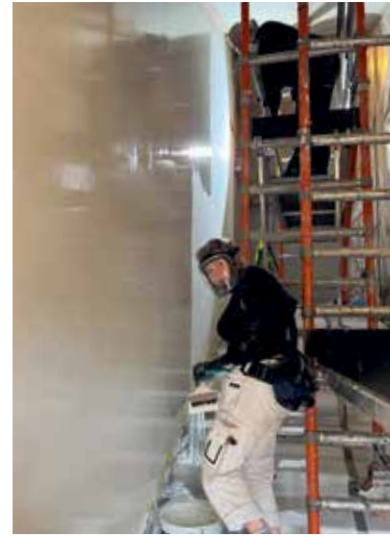
Uusi pinta rakennettiin modernien materiaalien päälle: liuotinpohjainen pohjamaali, polymeerivahvistettu tasoite ja kangastus, jonka päälle jälleen pohjamaali.
