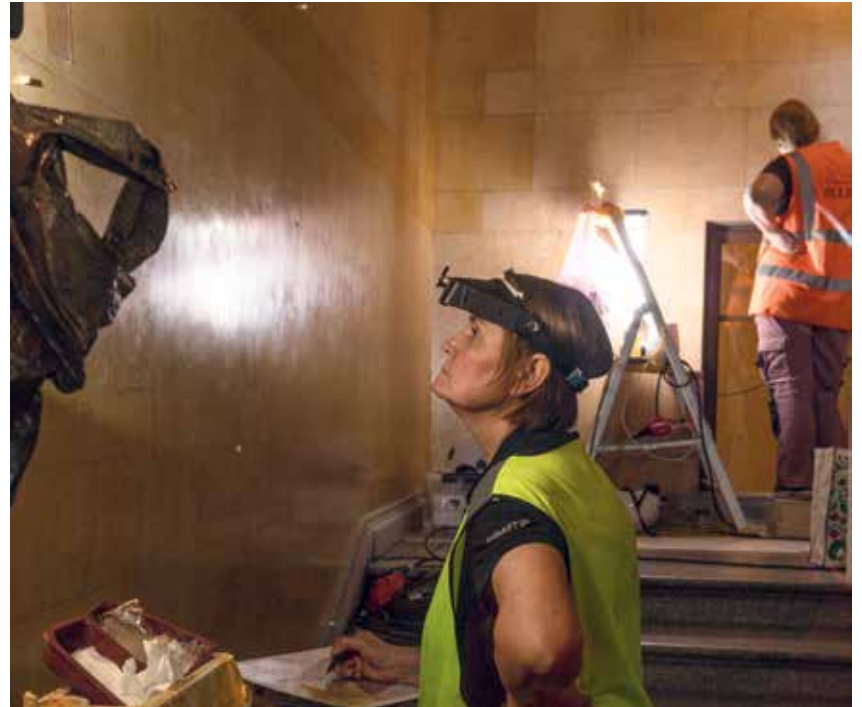
Eteläisen porrashuoneen konservointityöt olivat yksi hankkeen viimeisistä työsuorituksista ja porrashuoneessa oli parhaimmillaan kuusi henkeä kiinnitys- ja retusointityössä.
