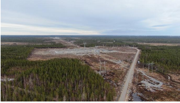
Sähkön siirtolinjan rakennustyöt maaliikuussa 2026 Halsualla.
